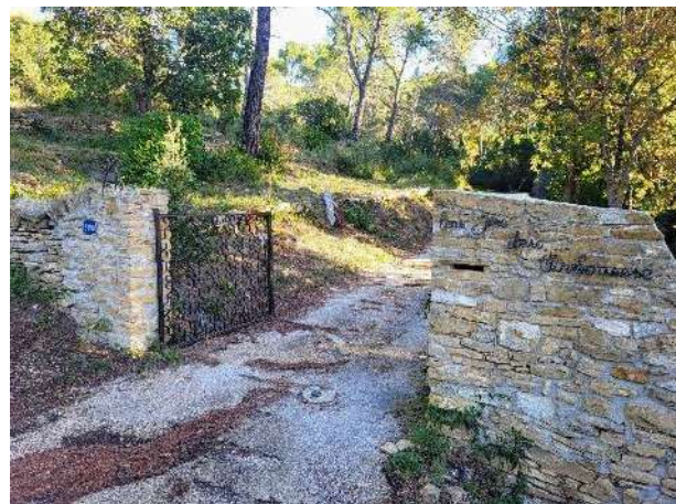
Portail de 3m de large qui donne accès à la propriété depuis le chemin carrossable
